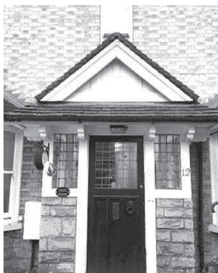
(写真22) Clockhouse 入口 看板は左の窓の下にある
