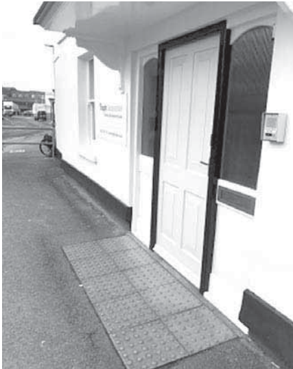
(写真18) NPOの入口はハイコントラストと点字ブロックで分かりやすい
