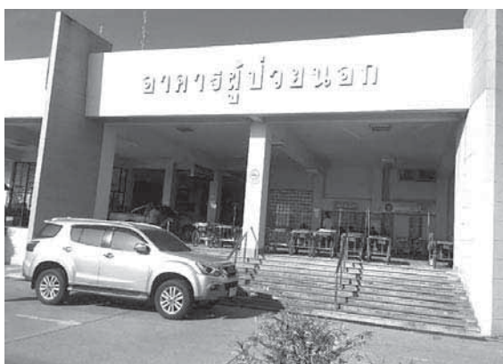
（写真8）ナムポーン病院
