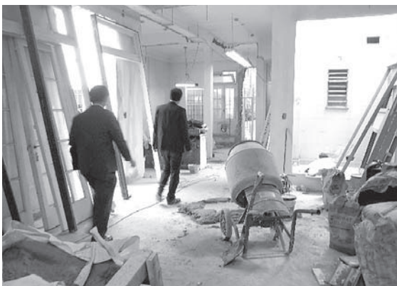
現在、建物の改築工事が進む
